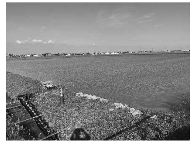
水田魚道の設置の様子
