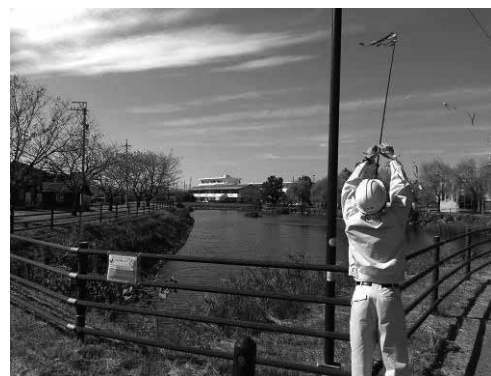
ため池の鳥よけ設置作業
